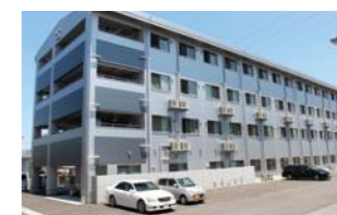
五岳寮(平成29年11月完成)
